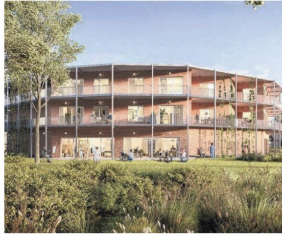
Een visuele voorstelling van het project: op het gelijkvloers zullen buurtbewoners een lokaal dienstencentrum en centrum voor dagverzorging vinden. Op de eerste en tweede verdieping zullen 20 assistentiewoningen gerealiseerd worden. (gf)
